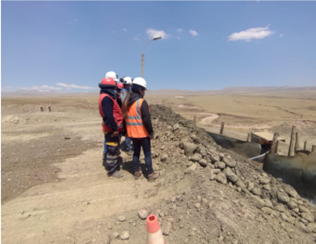
Figura 04: Supervisión de campo en chute.
