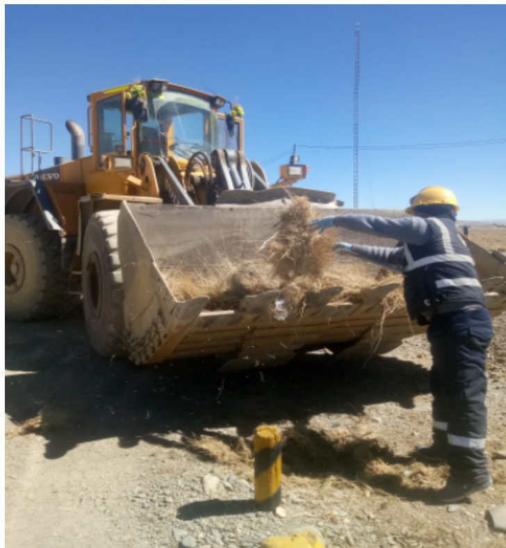
Figura 09: Mantenimiento de vías de acceso.
